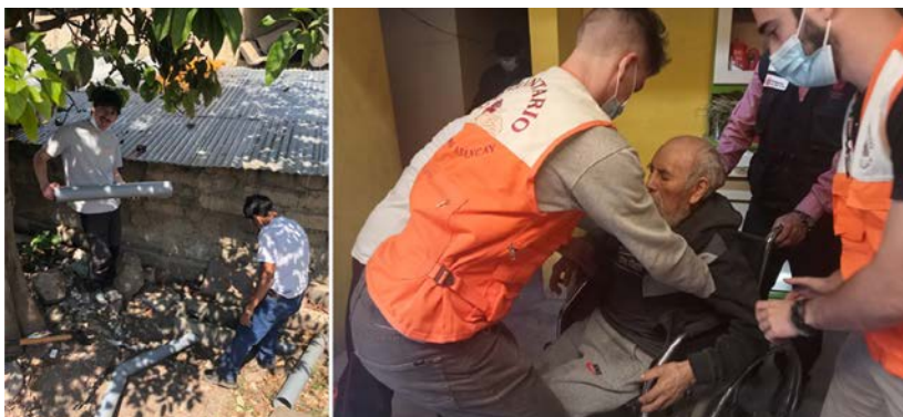
Figura 6.5. Trabajos sociales realizados con Caritas Abancay. Mediante experiencias, los alumnos aprenden diversas cuestiones constructivas y las realidades de la comunidad destinataria.
