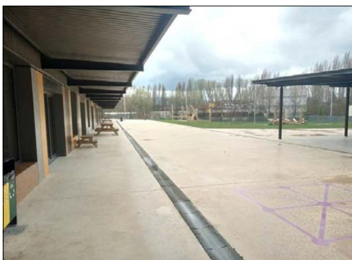
Figura 4. Vista de zonas 6 (cubierta 2) y 7 (zona de paso). Al fondo se ven las zonas 3 y 8
