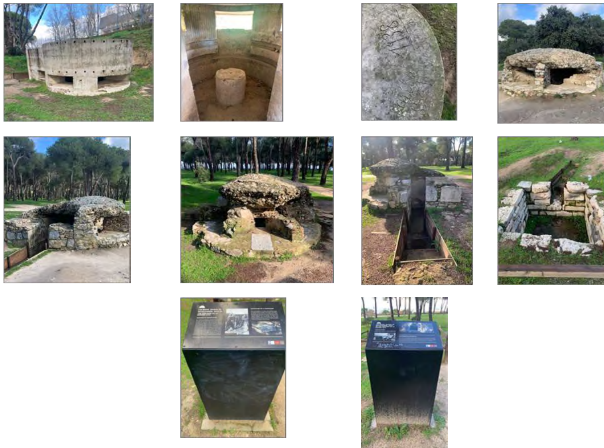
Figura 6.6. Fortines de la Dehesa de Navalcarbón tras su rehabilitación en 2022. Fuente: material fotográfico de los autores.
