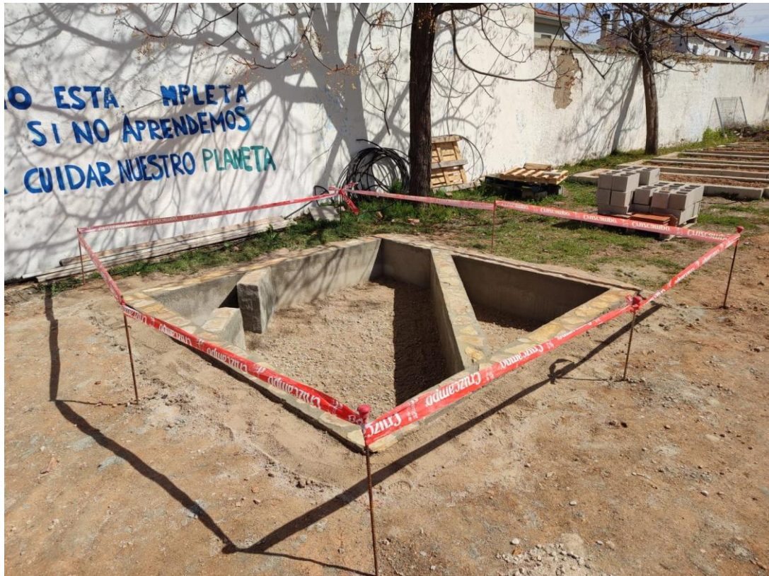
Figura 2. Construcción del arqueódromo
