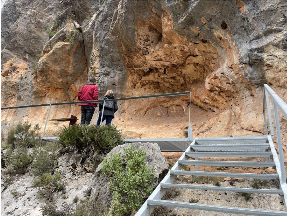
Figura 4. Acceso al panel de pinturas con cerramiento alejado de la pared
