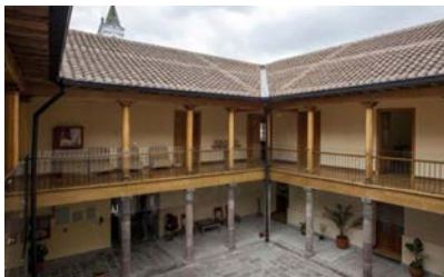
Figura 5.8. Casa quiteña tradicional de patio interior. https://www.elcomercio.com/construir/casonas-centrohistorico-patrimonio-quito-funcion.html
