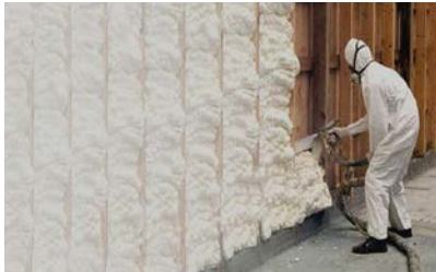
Figura 5.6. Espuma de poliuretano proyectado. https://www.albaniles.org/albanileria/espuma-de-poliretano-en-la-construccion-usos-ventajas-y-desventajas/
