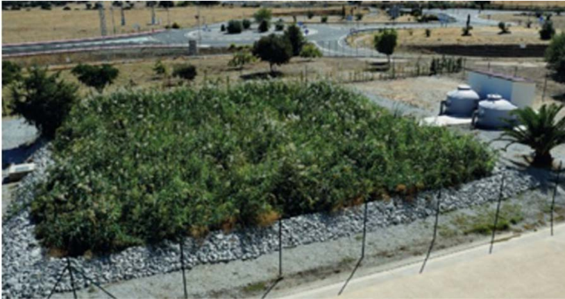
Figura 12.1. Planta de tratamiento con humedales artificiales instalada en el CCMIJU en Cáceres.
