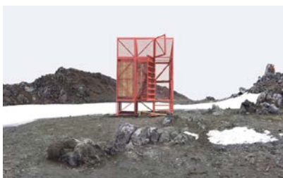
Figura 5.12. Estructura. Proyecto Refugio Antártico Ecuatoriano. http://www.arquitecturapanamericana.com/refugio-antartico-ecuadoriano/
