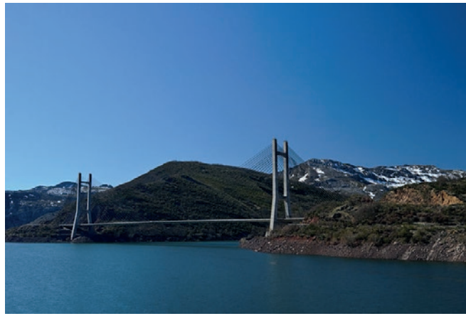
Figura 1. Puente Ingeniero Fernández-Casado en la Autopista A-66.
